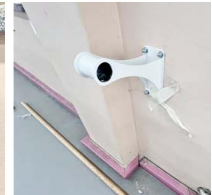
이번 작업에는 기본적으로 3부 세트양카를 사용하였으며, 벽면 콘크리트가 불안정한 구간은 케미칼 양카를 사용해 작업하였습니다. 철거 과정에서 일부 벽면의 상태가 고르지 않은 점이 확인되어, 해당 구간은 케미칼 양카로 보강하였고, 전체적으로 세트양카와 케미칼 양카를 함께 사용해 작업을 진행했습니다.
