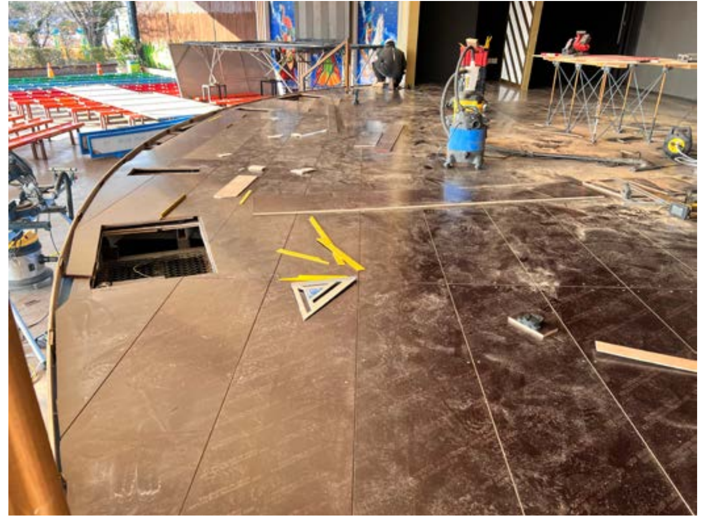
점검구를 따내고 마이크 자리, 스피커 자리, 전선, 무대 중간막 등 모든 모서리를 합치면 사각 물체 하나가 방 하나의 모서리, 즉 일반적인 직사각형의 연습실이 네 개의 모서리라면 여기엔 스피커나 마이크가 중간 중간에 네 개의 모서리를 만들고 이들이 직각을 이루는 것도 아니어서 매우 까다로운 가공 작업이 둘 쯤날에 진행되었는데 작업량이 많아 꽤 많은 시간이 소요되었습니다.
