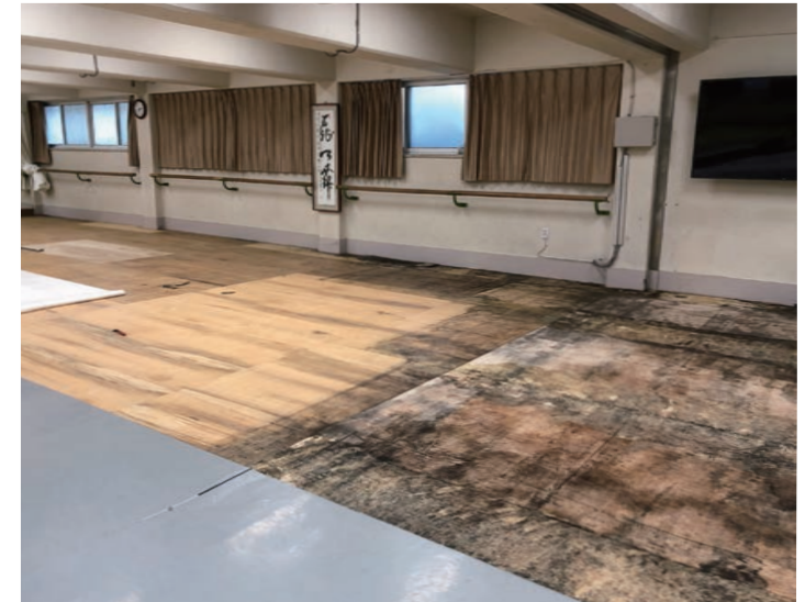
2023.12 ~ 2024.01 부산예술고등학교 공사 작업 중
