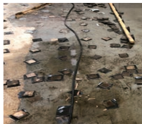
b. 철거 후 바닥 모습
