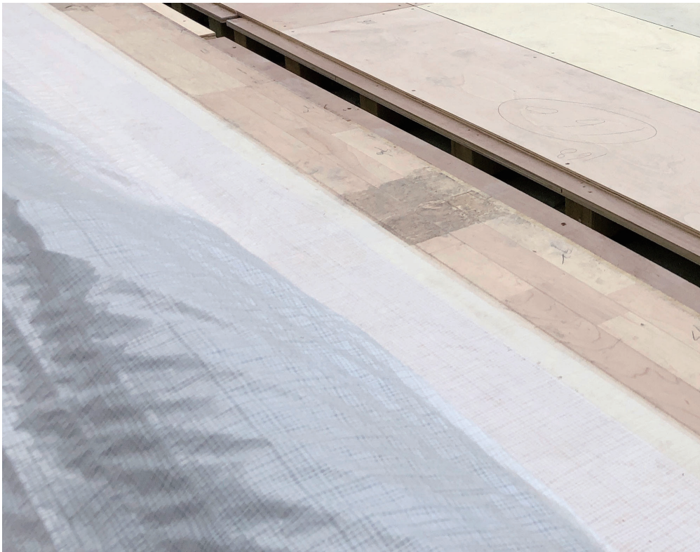
장선과 1층 레이어 구조작업 끝부분의 단차 해결
