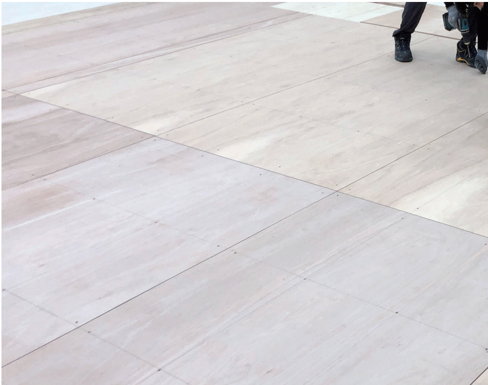
탄프무용마루 2층 구조 작업
