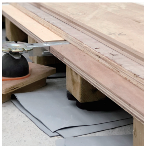
가장자리 장선 설치
