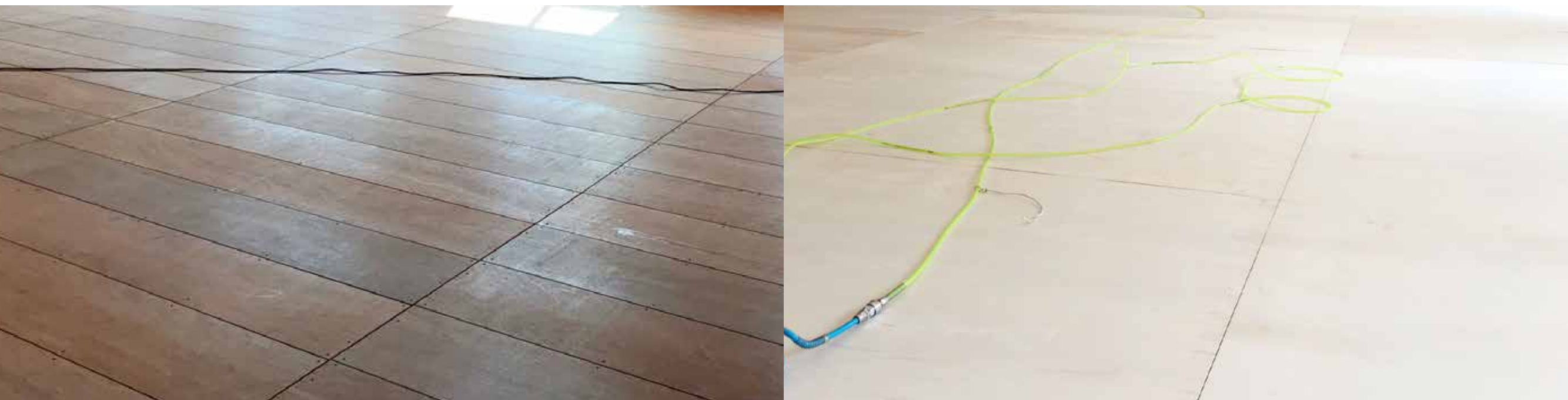
< 탄프하부마루틀, 충격흡수탄성형 설치 >
