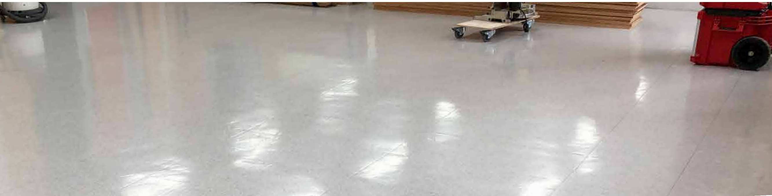
< 설치 전, 데코타일이 깔려있는 상태 >
