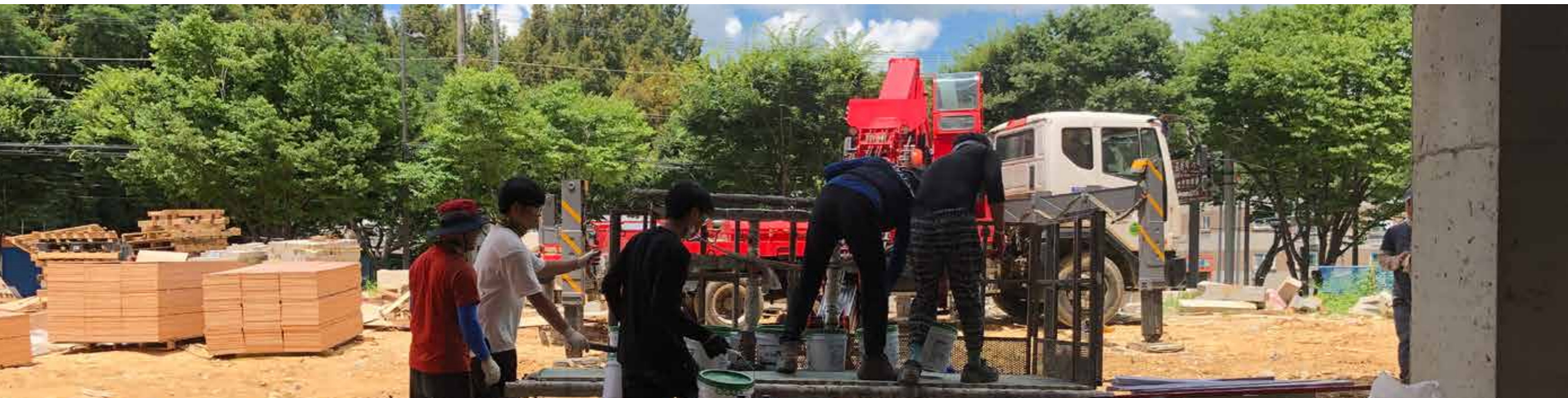
<마루기술인력 3인, 매트기술인력 3인, 보조인력 6인>
