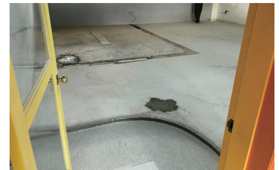
시공 전, 현장
